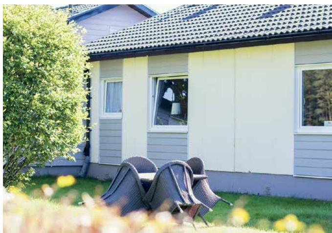
UNDERHÅLL PÅ GÅNG: Nu är fönsterbyten och fasadrenoveringarna på Mörländavägen 1, 3 och 5 i stort sett klara.
