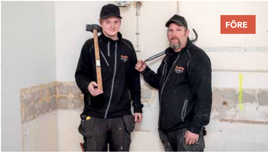
Axel och Henrik Lindström i en lägenhet som just nu stamrenoveras. Här har de rivit ut köket innan det är dags för bland annat kakelsättare och elektriker att göra sin del av arbetet.
